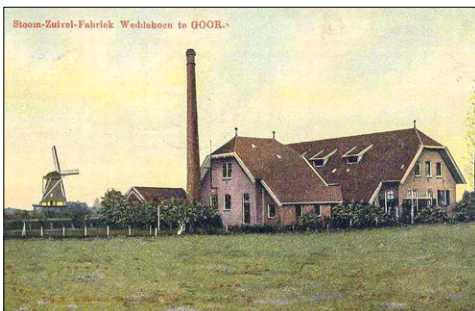
Stoomzuivelfabriek Weddehoen in Goor
